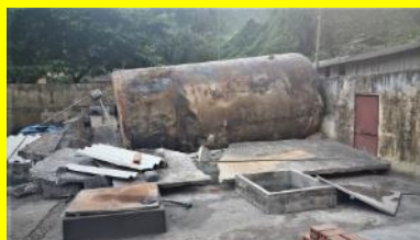
Hình ảnh của chiếc bồn chứa ngầm sau khi lũ lụt đi qua
